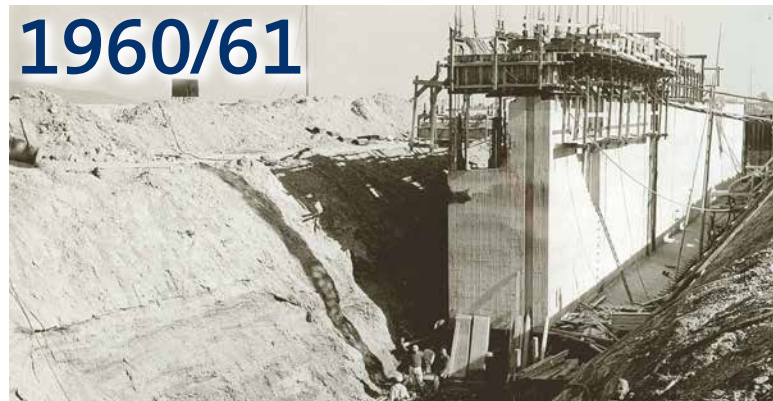
Neubau Osthafen Regensburg
